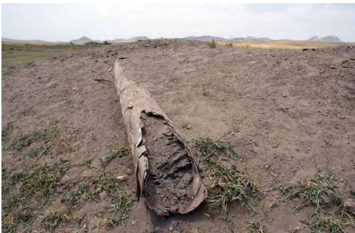
Рис. 28 Чонкой – Улуг-Тоо: сухие хвосты и пульпопровод (2008 г.)
