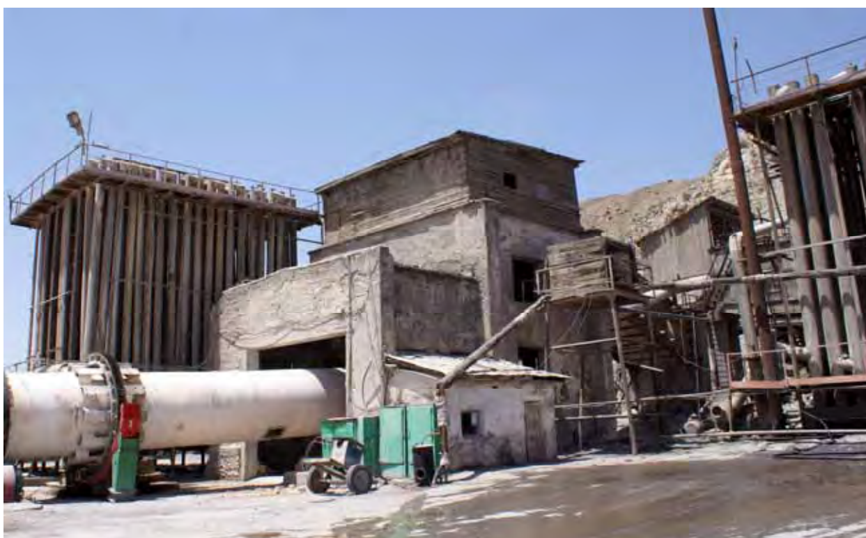
Рис. 20 Барабанные печи и конденсатор
