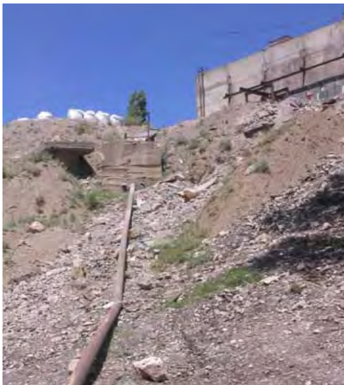
Рис. 23 Обогащительная фабрика и пульпопровод
