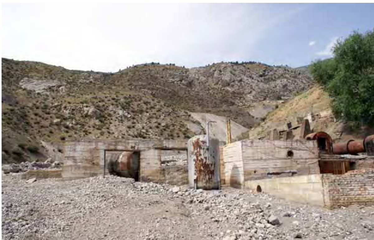
Рис. 31 Чаувай: разрушенная вращающаяся печь и завод (2008 г.)
