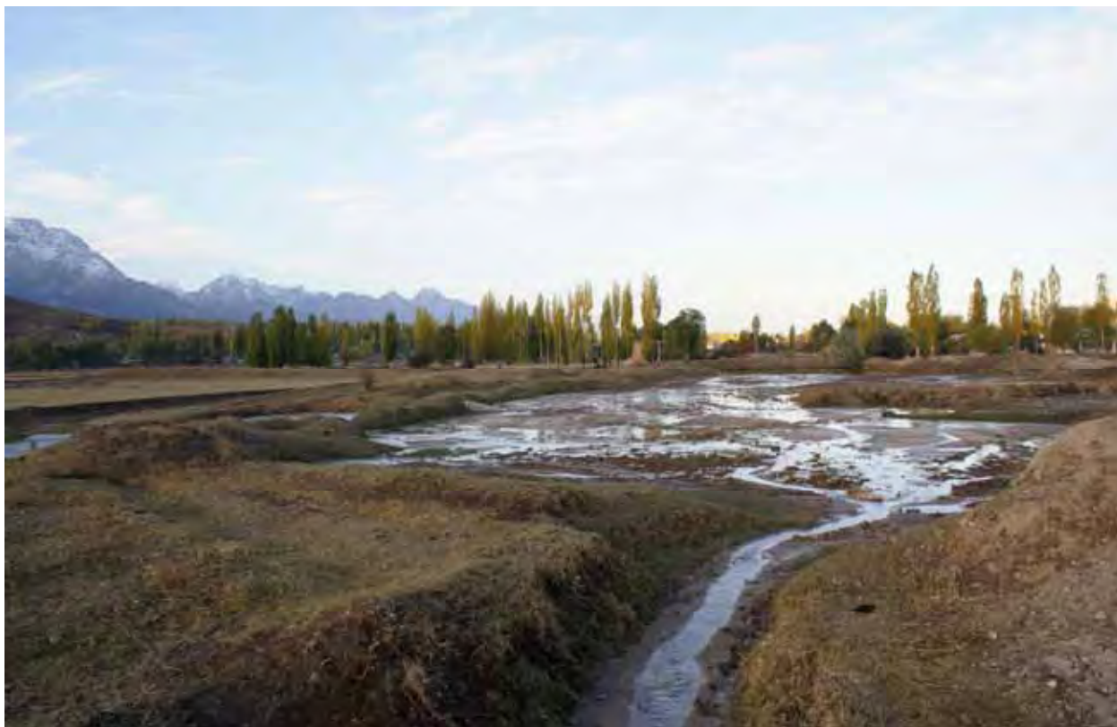
Рис. 17 Приемник стоков и шламонакопитель металлургического завода (2008 г.)
